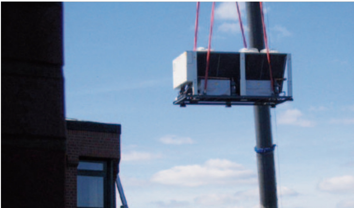
Die Kälteanlage wird ins Rathaus eingebaut
