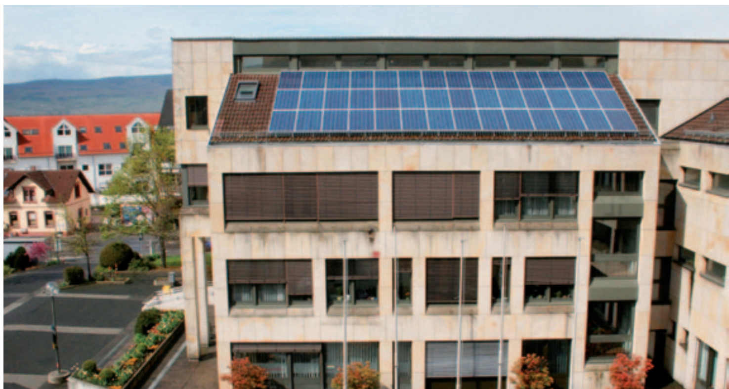
Photovoltaikanlage auf dem Rathausdach
