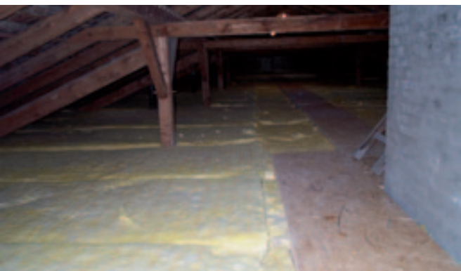
Schuldachboden bei Einbringung der Dämmung
