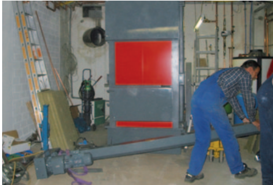
Der Pelletkessel wird im Rathaus eingebaut
